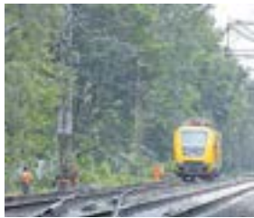
Der Reparaturzug und Bahnmitarbeiter mit Motorsägen sind dabei, die Oberleitung von Ästen zu befreien und wieder in Ordnung zu bringen.
